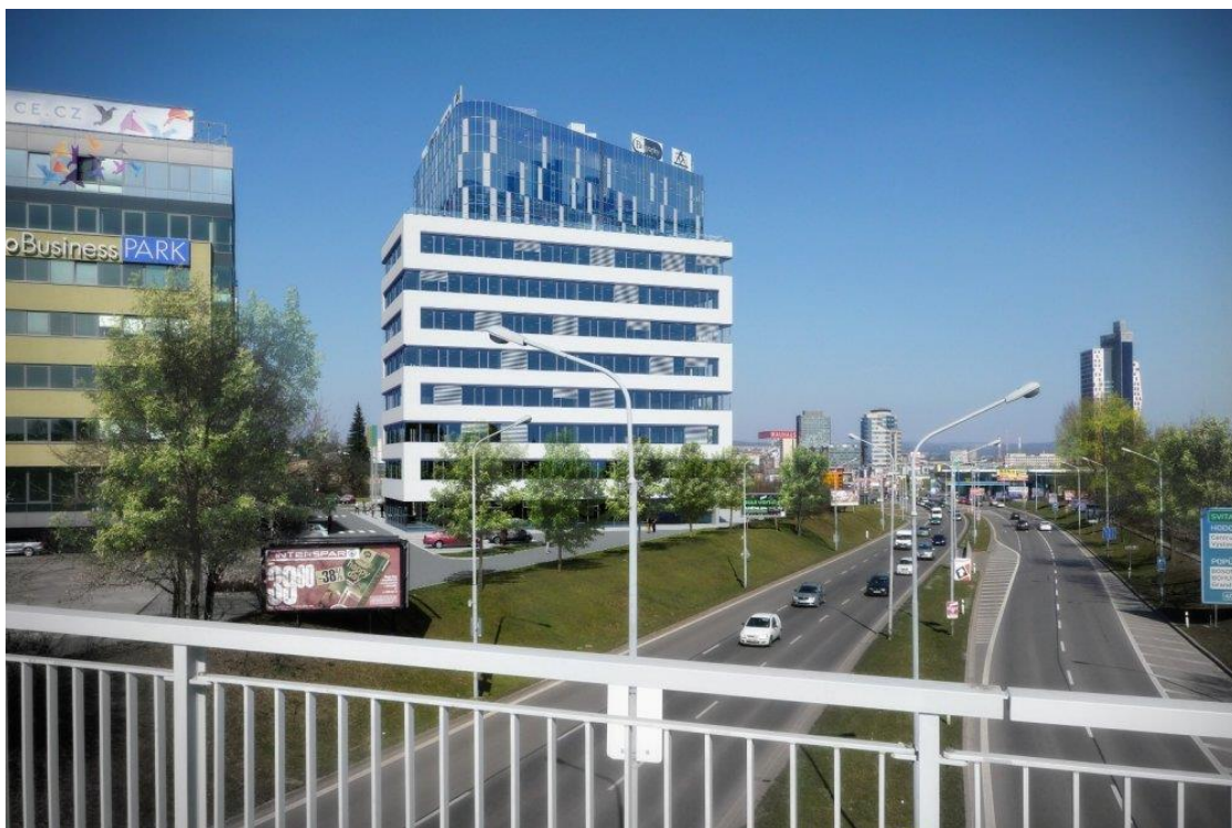
Zkolaudovaná budova E – BBP OFFICES
