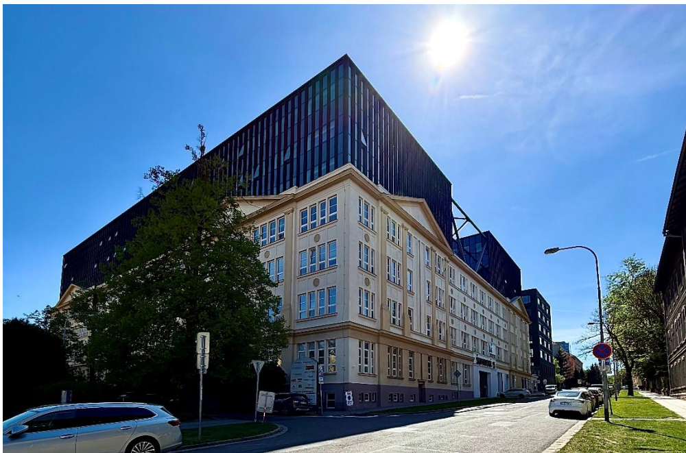
Zkolaudovaná nástavba Cerit Science Park II – CENTRUM ŠUMAVSKÁ
