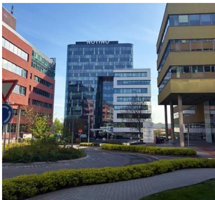
Zkolaudovaná budova E – BBP OFFICES
