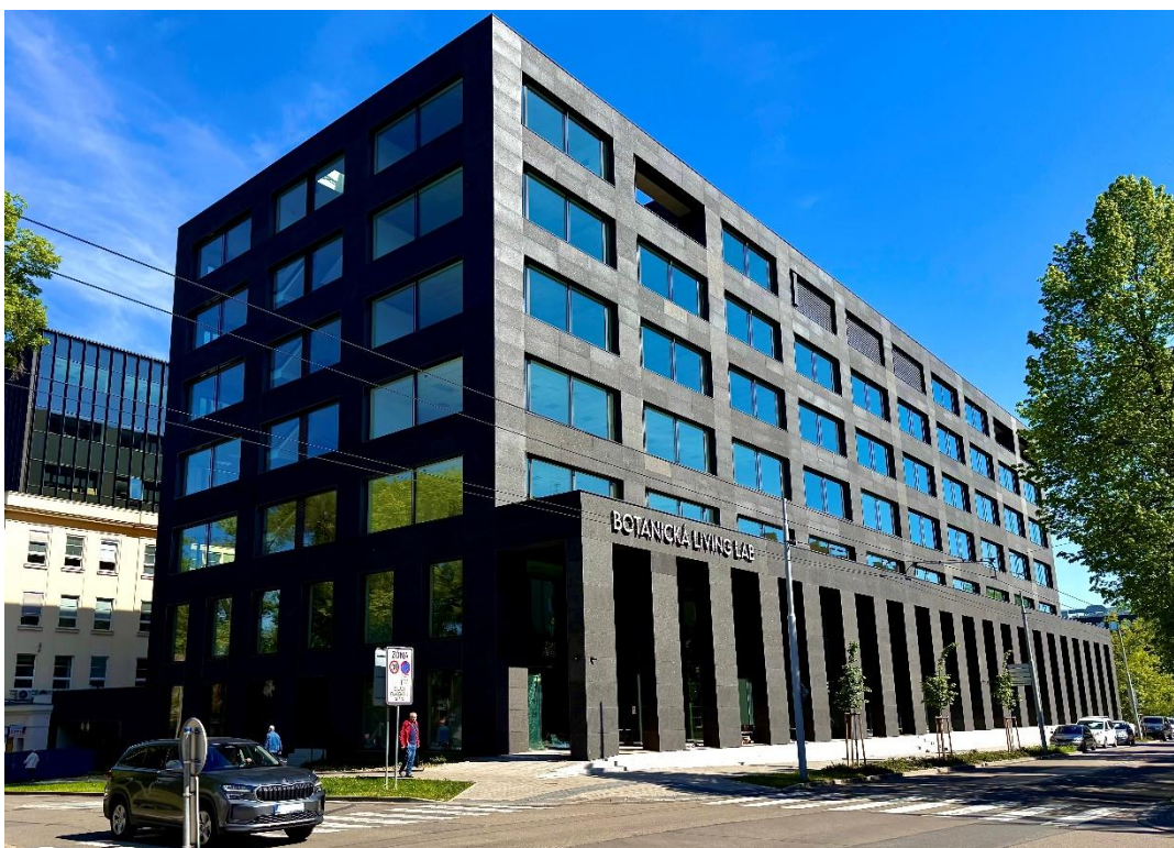
Zkolaudovaná budova Cerit Science Park III
