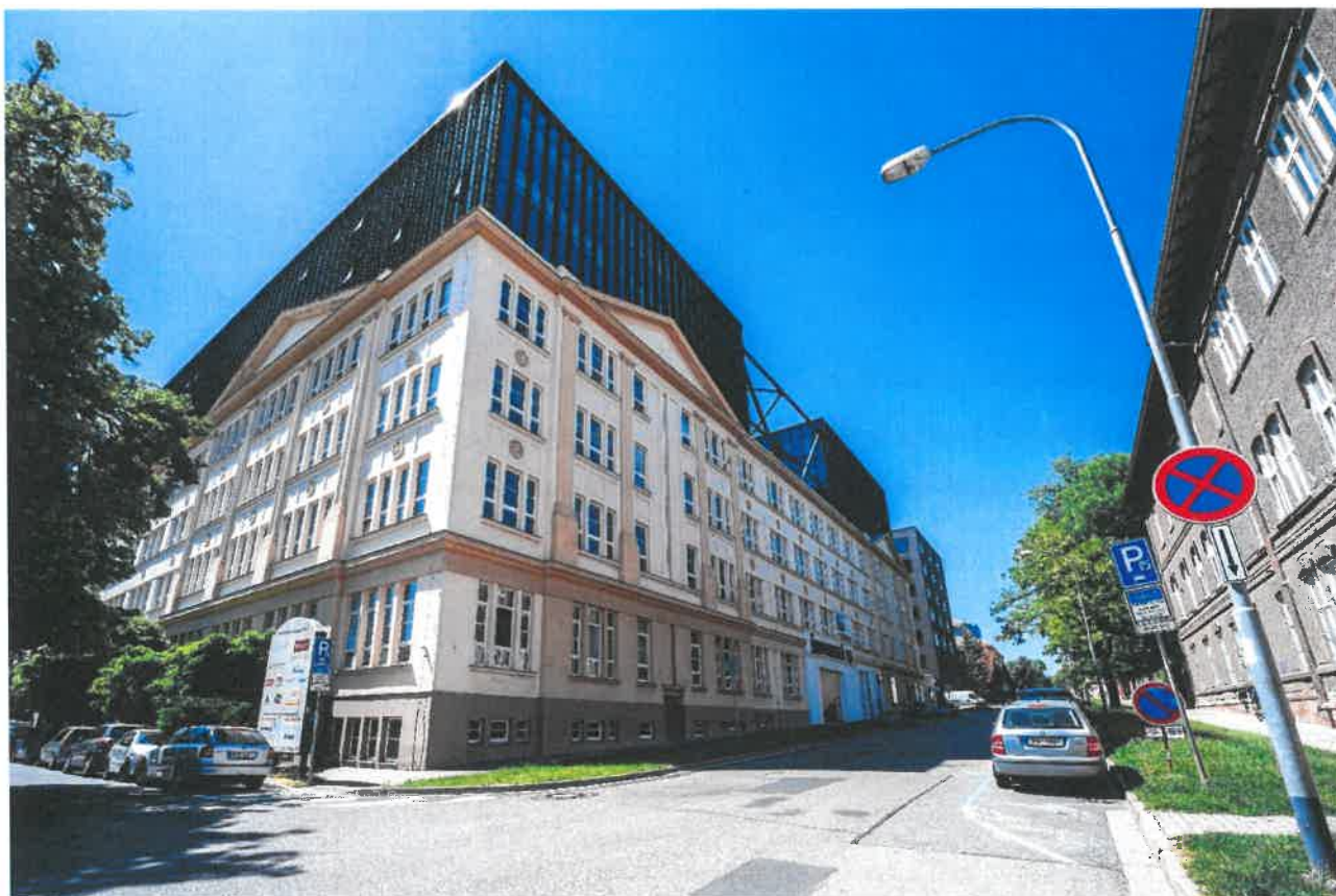
Nástavba Cerit Science Park II – CENTRUM ŠUMAVSKÁ
